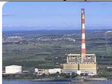
Centrale d'ARAMON - EDF
