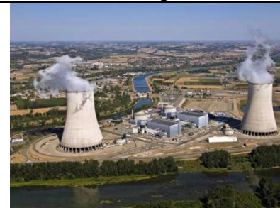
Centrale de GOLFECH - EDF
